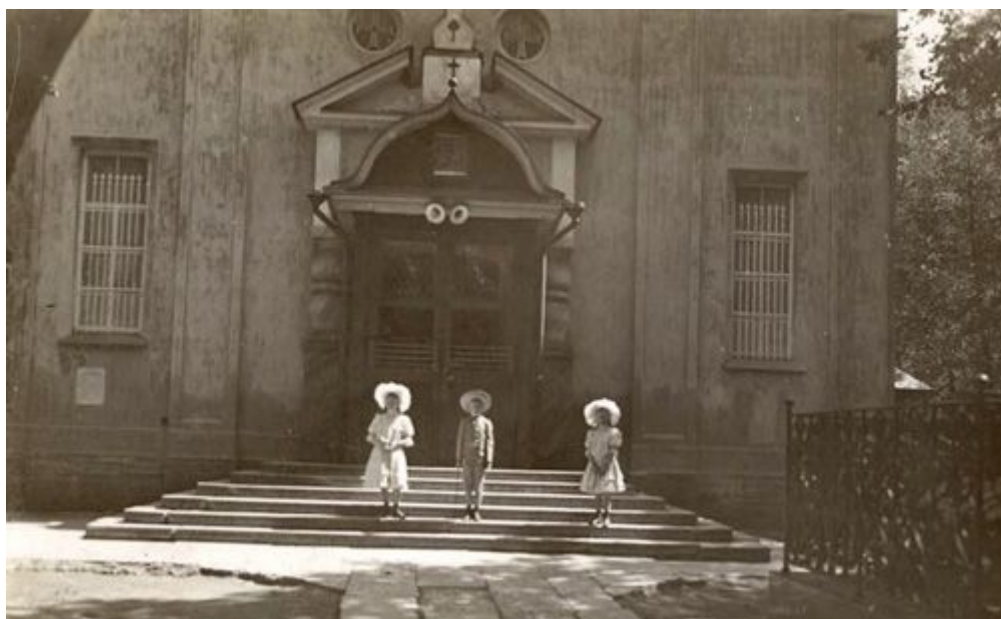
13. Fragment západní fasády kostela Věch svatých na hřbitově Volkov.
