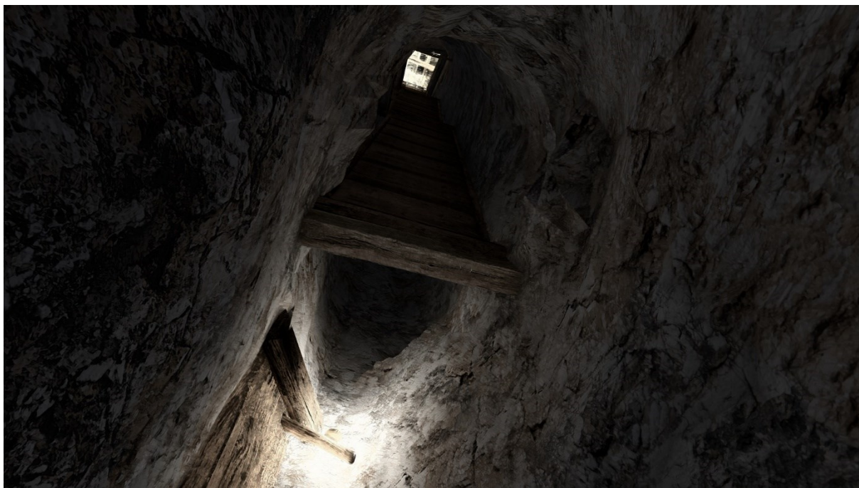
Obr. 142: Pohled do šachty kam byly nově vloženy větrací přepážky.
