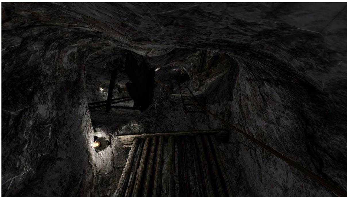
Obr. 139: Pohled na sestup hlavní zdokumentovanou šachtou, kde byla zachována výdřeva, žebřík a dřevěná přepážka.
