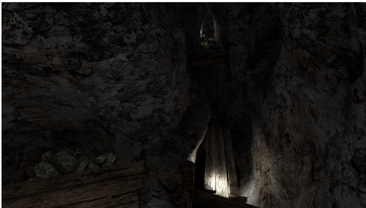
Obr. 140: Pohled na část štoly, kde byly dochovány rozpěry.
