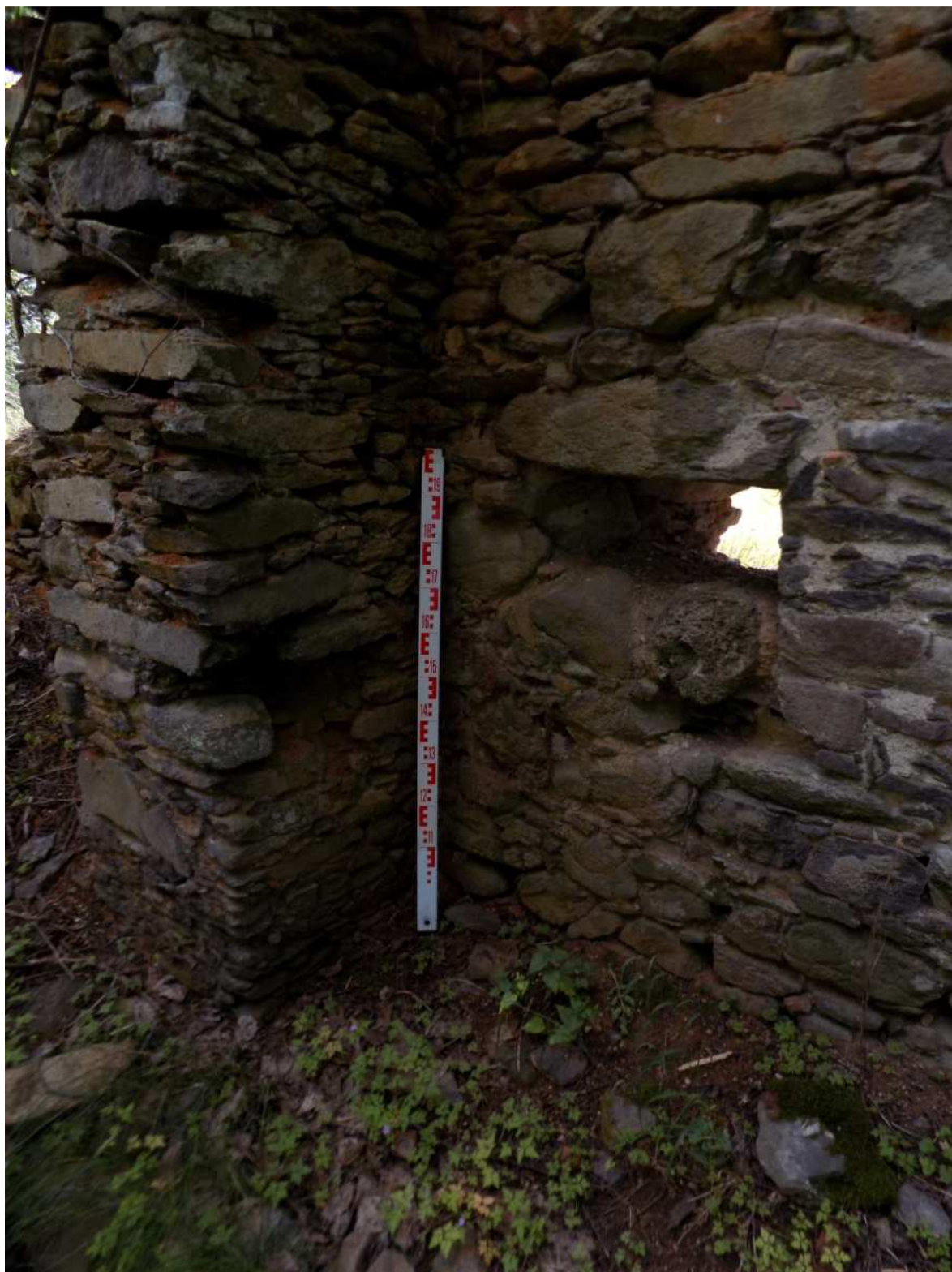
Obrázek 118: Volfštejn. Objekt č. 7 – západní zeď delší ze stran obdélného objektu. Foceno ze západu.
