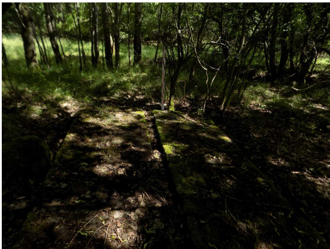
Obrázek 119: Volfštejn. Objekt č. 8 – vnitřní plocha objektu s betonovými deskami.
