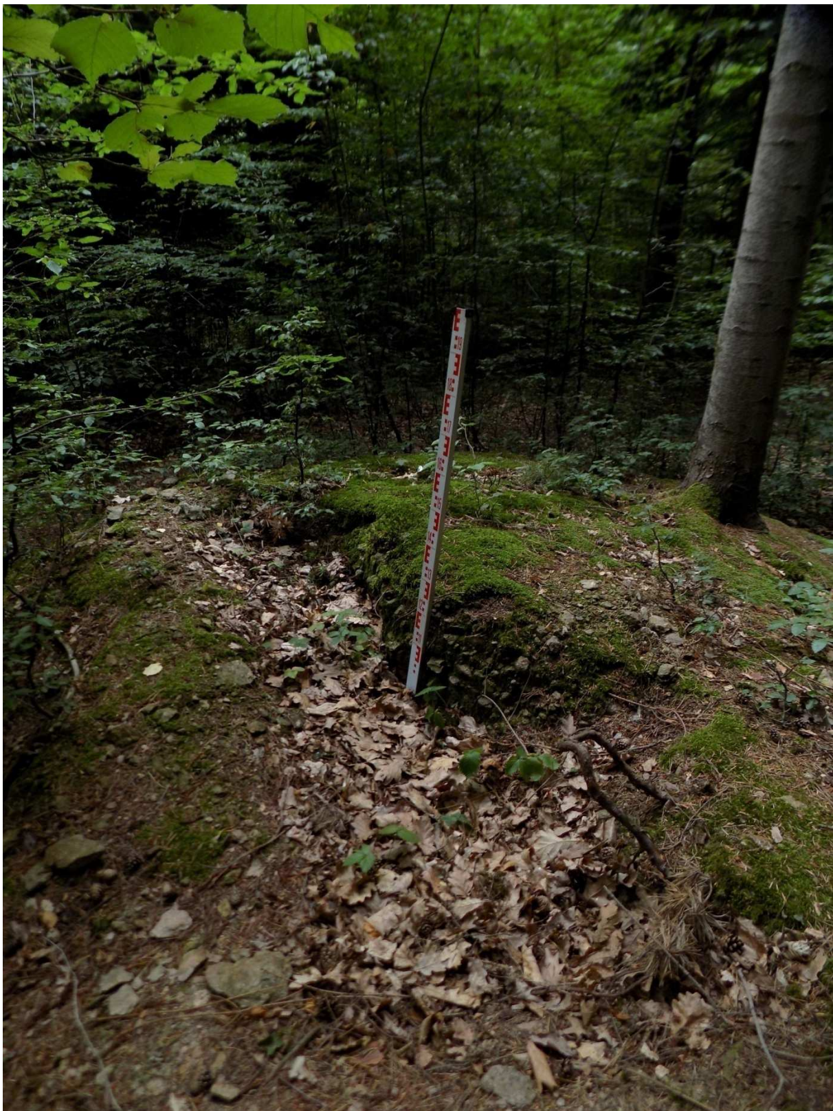
Obrázek 29: Červenice. Narušení valu vnějšího opevnění hradu. Foceno od jihovýchodu.
