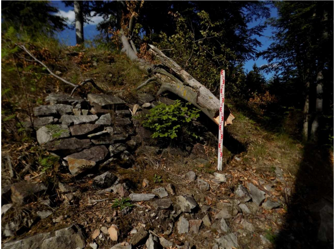
Obrázek 34: Hengst. Objekt č. 1 – kamenná plenta při jižní straně objektu. Foceno z jihu.
