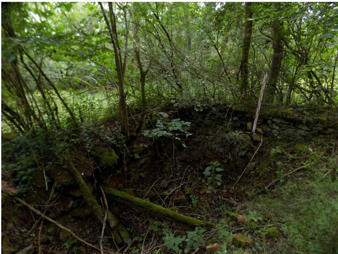
Obrázek 127: Volfštejn. Objekt č. 12 – vnitřní zahloubená plocha objektu a jihozápadní nároží v pozadí. Foceno ze severovýchodu.
