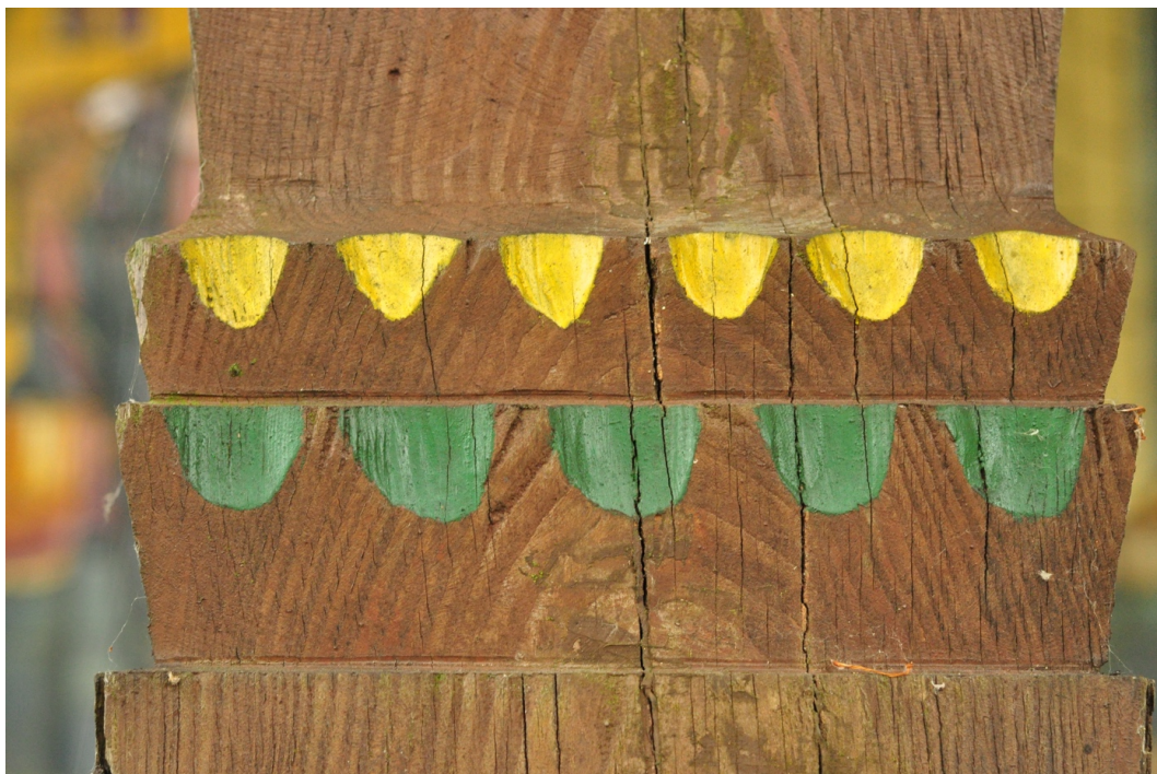
32. Svatý Hostýn, kaple křížové cesty, polychromovaný detail trámu
