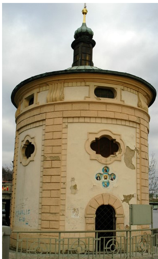
42. Praha, Kaple Máří Magdalény na nábřeží, pohled na venkovní fasádu.
