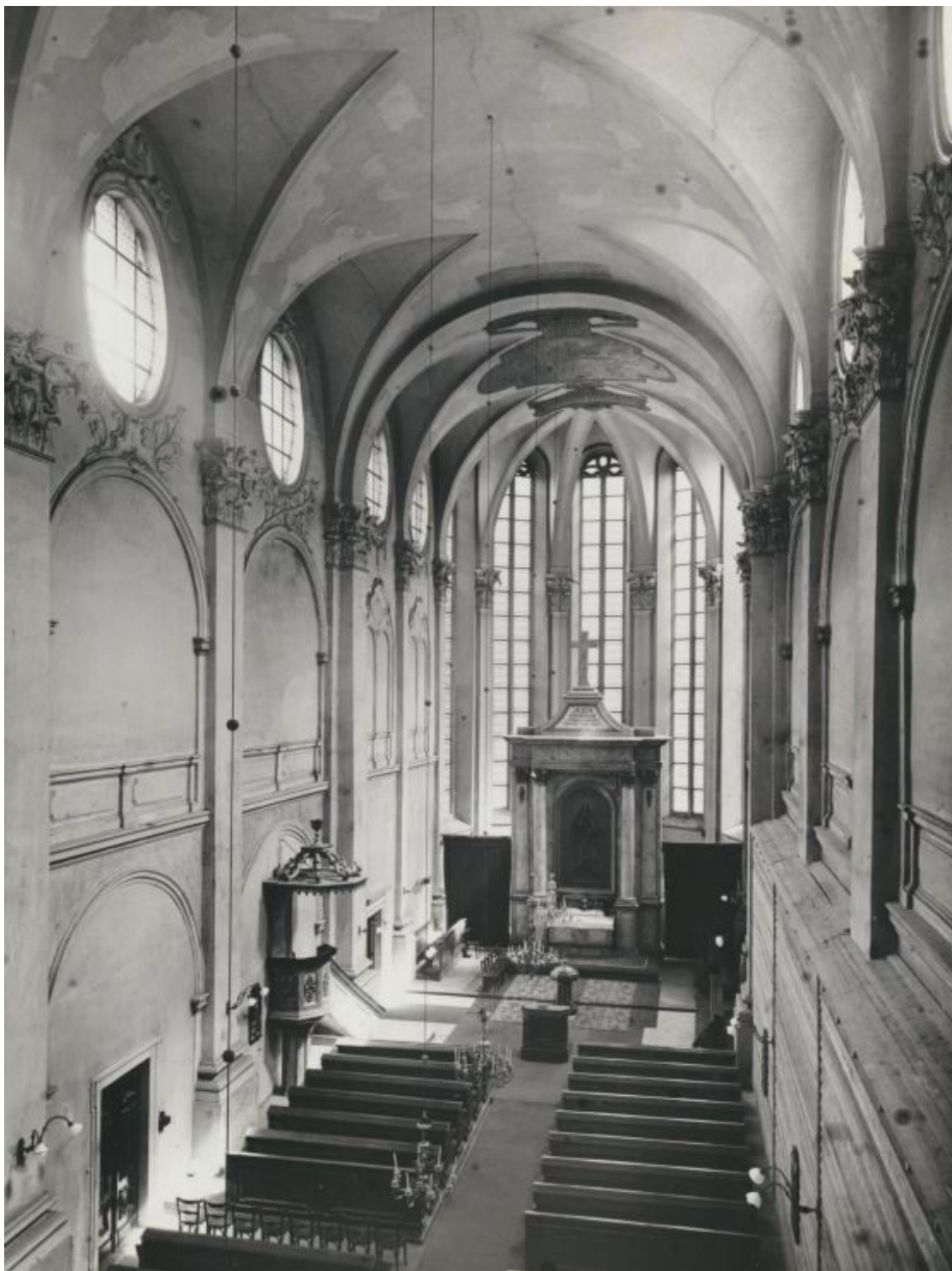
12. Praha , kostel sv. Salvátora, fotografie východní strany kostela před zahájením stavebních úprav ve 20. století, se zachycenou vyzdívkou bočních lodí.
