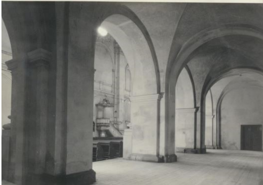
15. Praha , kostel sv. Salvátora, fotografie stavu kostela po odstranění vyzdívek, 1947.
