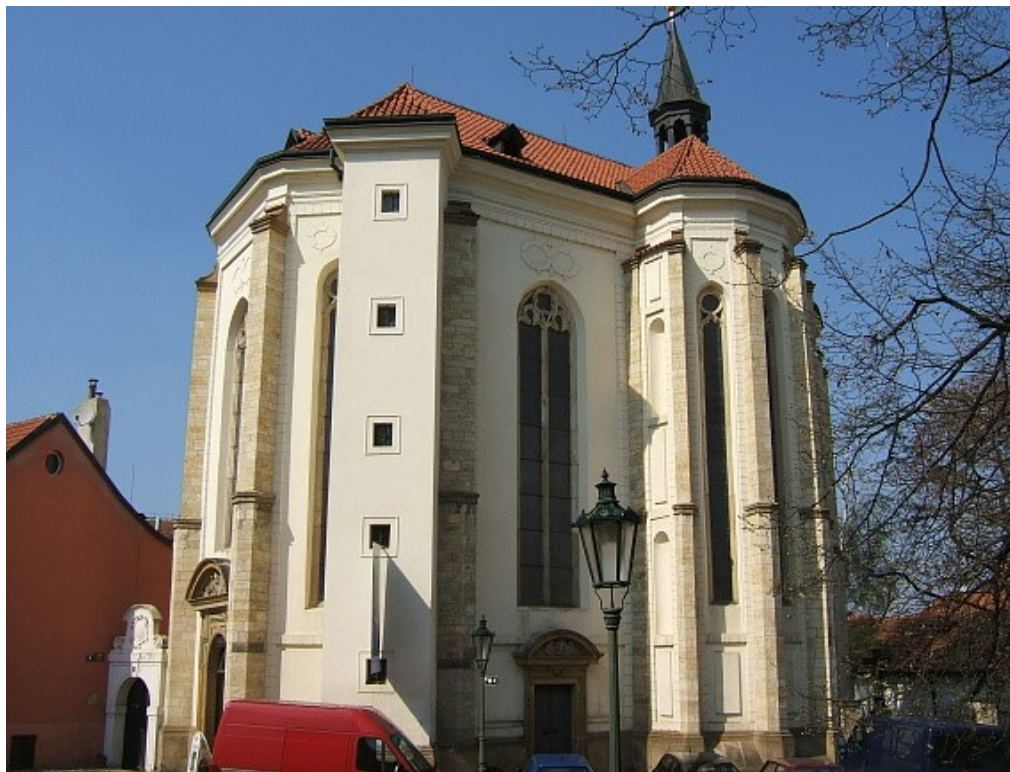
38. Praha , Kostel sv. Rocha na Strahově, pohled na boční fasádu.
