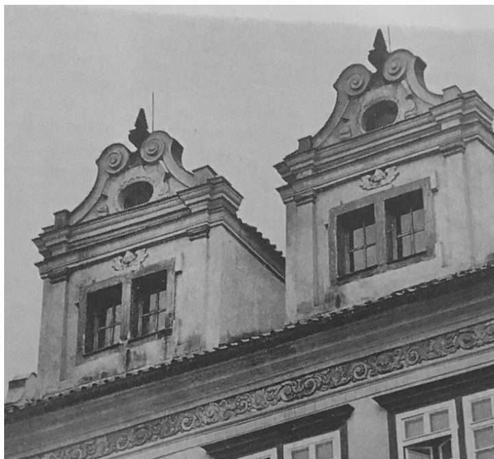
44. Praha , dům čp. 4 na Malém náměstí, kartušová okna ve štítech.
