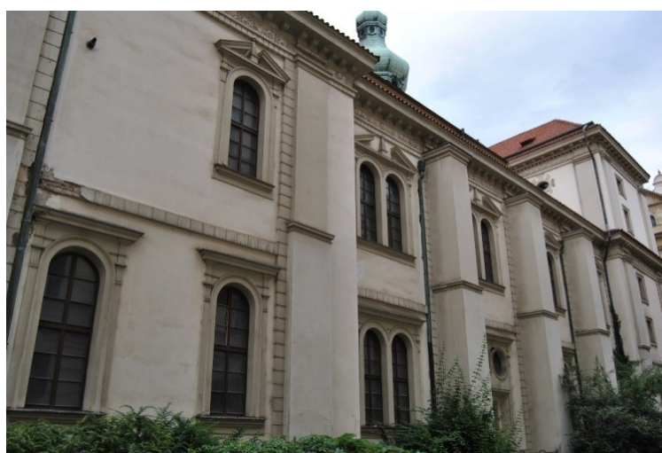
25. Praha, kostel sv. Salvátora, pohled na severní stěnu kostela.
