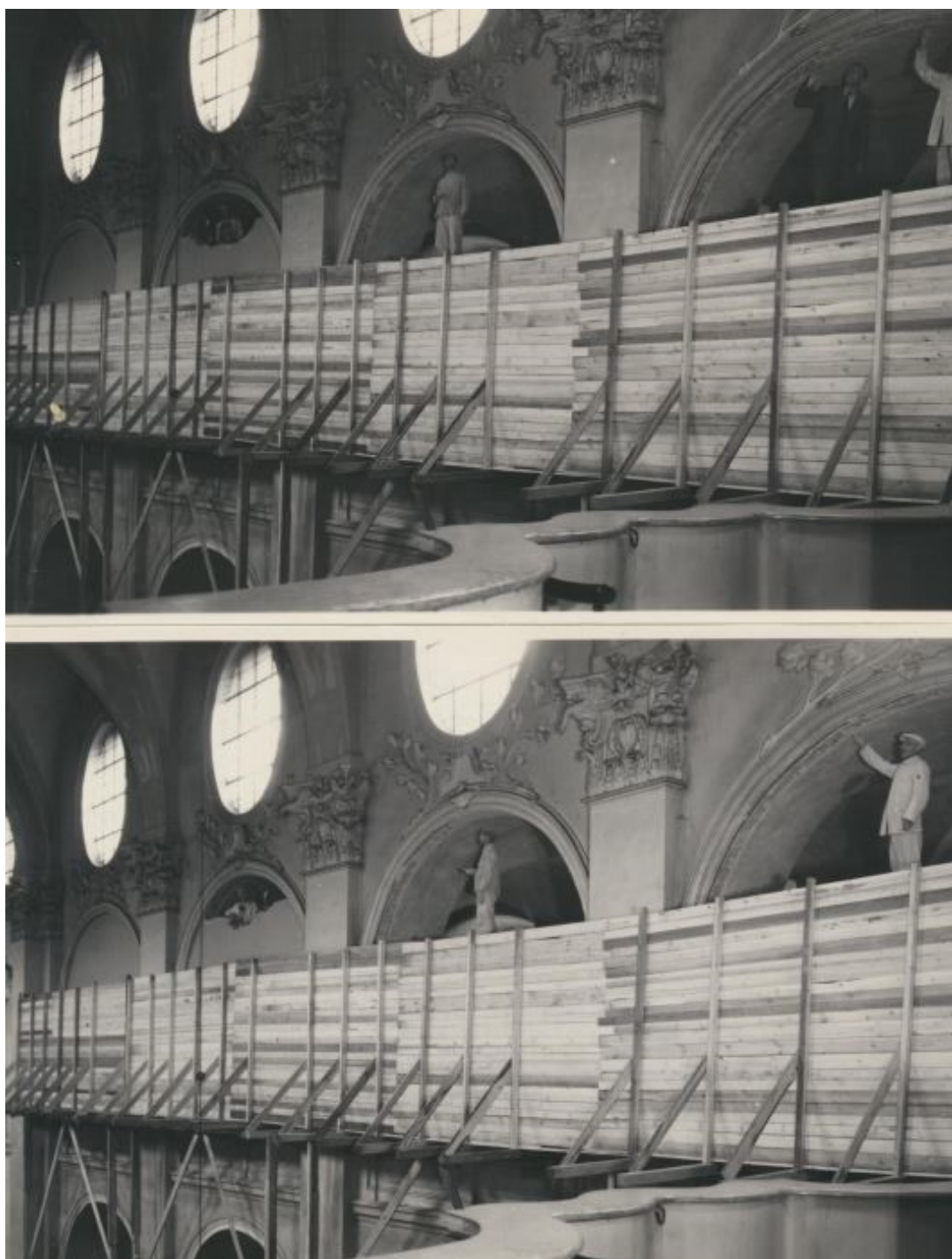
14. Praha , kostel sv. Salvátora, fotografie z probíhajících renovací oblouků, 1947.
