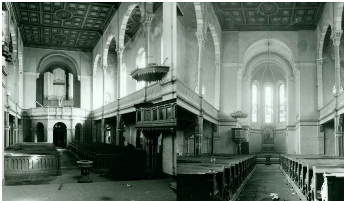
Původní podoba interiéru kostela před rokem 1976, kdy byl demolován. Zdroj: NPÚ, ÚOP v Liberci.
