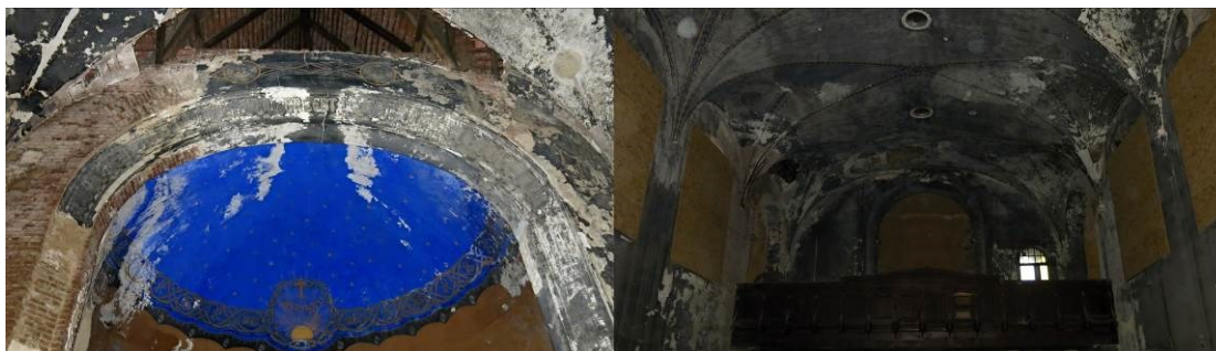
Detail vítězného oblouku a klenby presbytáře se zbytkem původní modré výmalby. Vpravo klenutí lodi skořepinovou armabetonovou klenbou. Foto autorka 2015.
